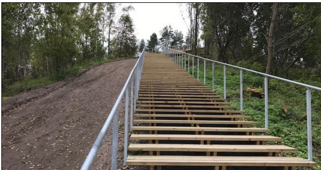
Kuva 43. Puttosharjulle voitaisiin rakentaa Paloheinän täyttömäen kaltaiset kuntoportaat (Länsiväylä 27.9.2017).
