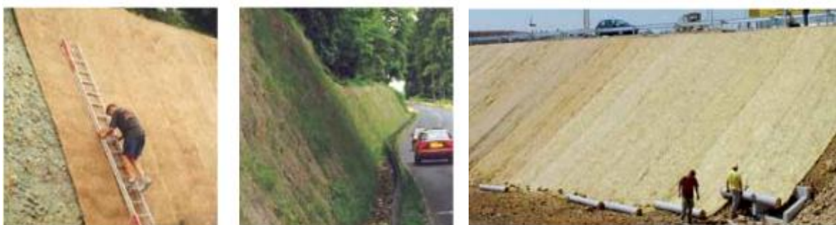
Kuva 29. Eroosiomatot sopivat jyrkkien ja kivisten luiskien suojaksi (EG-Trading Oy 2010).
