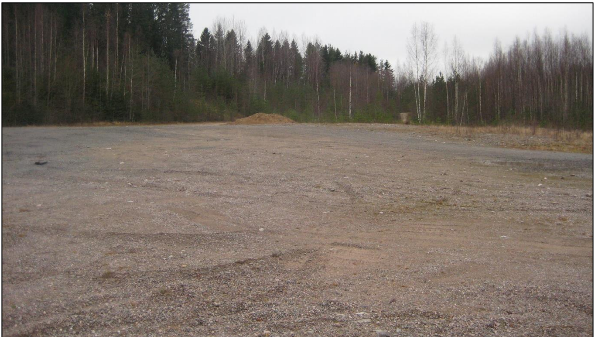
Kuva 23. Puttosharjun maa-ainesten ottamisalueella on laajoja kasvillisuudesta paljaita alueita.
